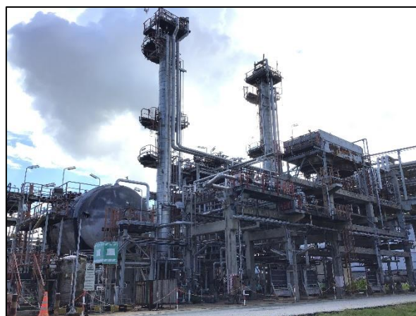
รูปที่ 2-13 ระบบแยกก๊าซออกจากน้ำเสีย (SWS)
