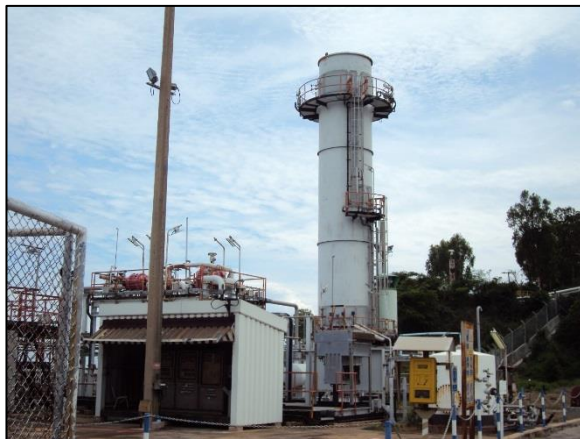
รูปที่ 2-2 ระบบควบคุมไอระเหย (Vapor Control Unit: VCU)
